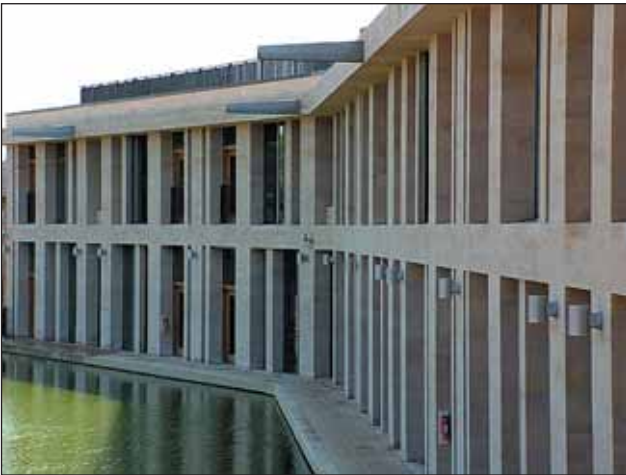
Bild 1. Das SciTec Zentrum der Oundle School vereint Wissenschaft, Kunst und Technik und wurde mit zukunftsgerichteten nachhaltigen Technologien wie KNX erbaut. Quelle: Andromeda
